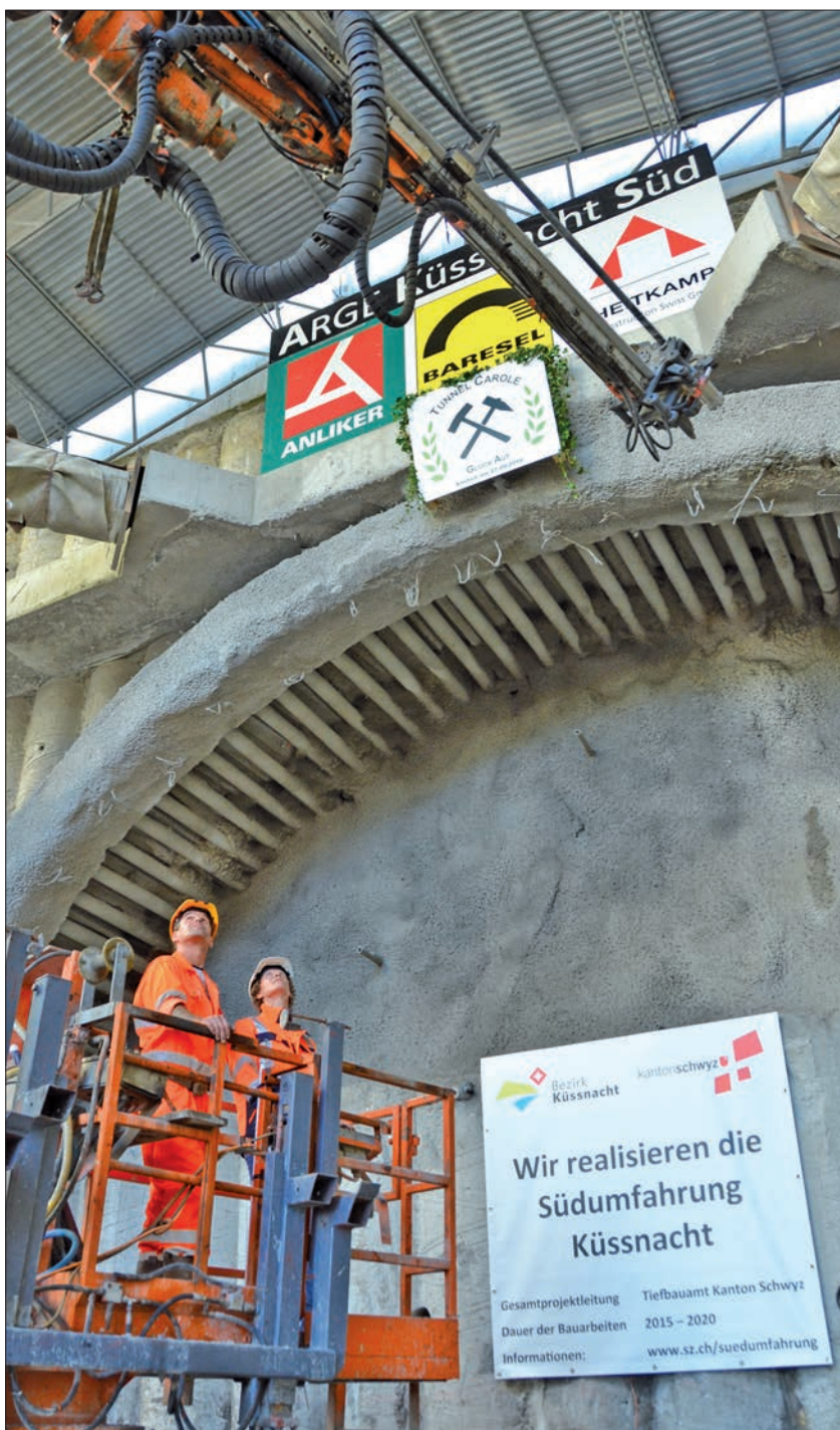
Zusammen mit einem Mineur dirigierte Carole Mayor den Bohrkopf der Tunnelbohrmaschine zu ihrem allerersten Einsatz im Tunnel Burg.
