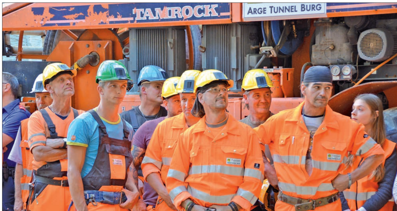
Sie wählen sich nun 350 Meter durch den Berg: die erfahrenen Mineure aus Kärnten.
