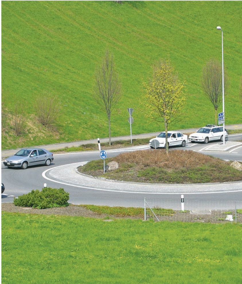
Das Bundesamt für Strassen hat entschieden: An der Autobahnausfahrt Küssnacht soll eine Lichtsignalanlage statt des Kreisels zukünftig für höhere Verkehrssicherheit und eine Verflüssigung des Verkehrs sorgen. Bereits 2017 wird voraussichtlich mit den Umbauarbeiten an der Autobahnausfahrt im Fänn begonnen. Foto: FS-Archiv
