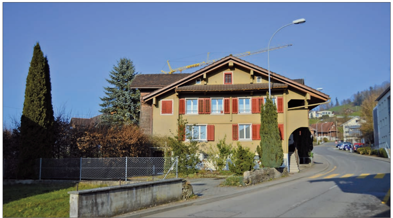
Günstig und kurzfristig zu haben: Der 435-jährige Kern des Hauses an der Seebodenstrasse 23.
