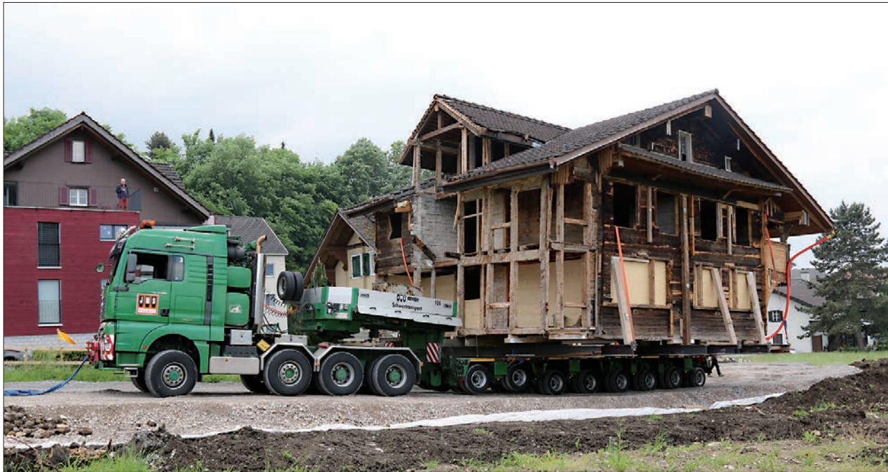
Behutsam, vorsichtig und Kollateralschaden vermeidend, bewegte sich das historische Holzhaus auf seinen Zwischenlagerplatz zu.
