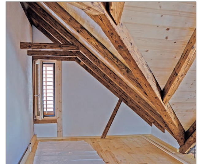
Kontrastreich: Die alten dunklen Balken heben sich deutlich vom neuen Verputz und Deckenholz ab.
