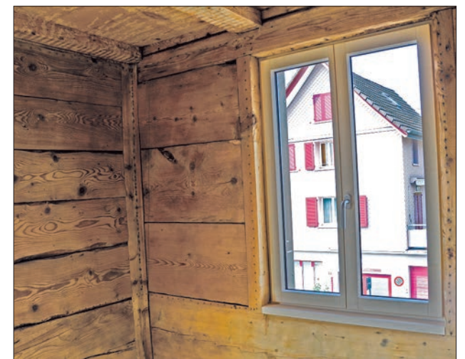
Die handbehauenen Holzwände wurden gebürstet und mit Seifenwasser behandelt.
