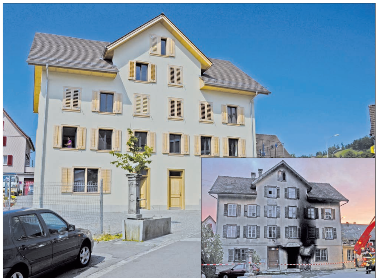
Das Haus an der Rigigasse 33/35 im Jahr 2009, direkt nach dem Briefkastenbrand (kleines Bild) und wie es sich heute nach der Renovation präsentiert.
