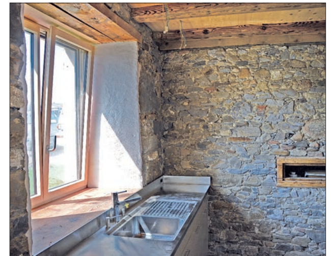
Dank der 60 cm dicken Bruchsteinmauer ist es im Sommer in der Küche im unteren Geschoss angenehm kühl.
